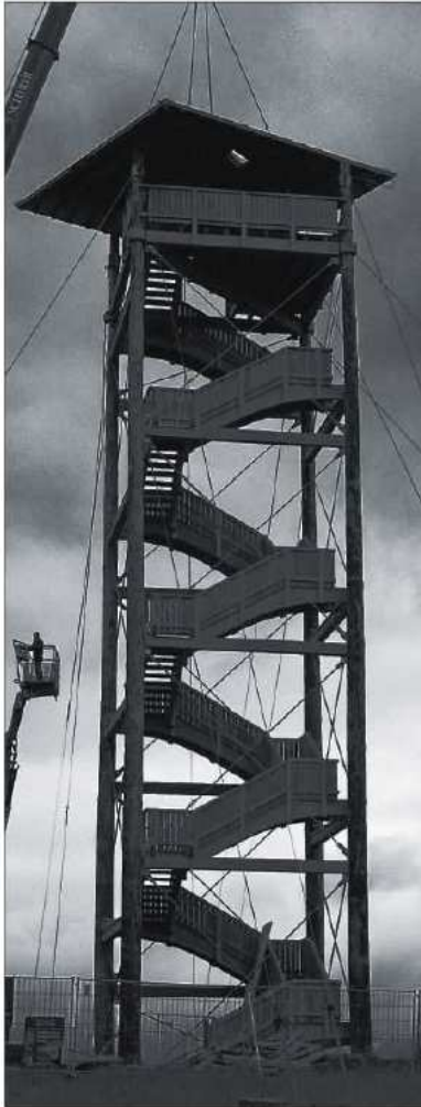
Gestern Morgen hievte ein Autokran das vormontierte Dach auf den neuen 24 Meter hohen Aussichtsturm auf dem Heimberg bei Schloßböckelheim. ■ Foto: Wilhelm Leyendecker ■ E0406wid1
