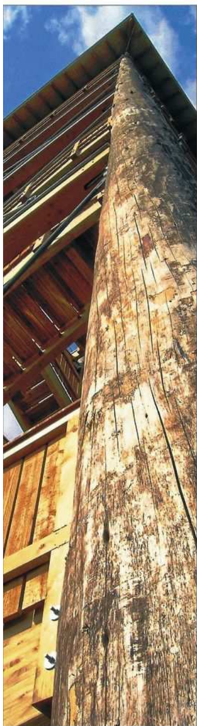
Bis zur Dachspitze hinauf misst der hölzerne Heimberg-Turm 29 Meter, die letzte Plattform ist 24 Meter hoch. An den vier Seiten ist die Konstruktion an Baumstämmen aufgehängt. Ein luftiger Entwurf, der auch Stürmen standhalten soll. E1207mz3
