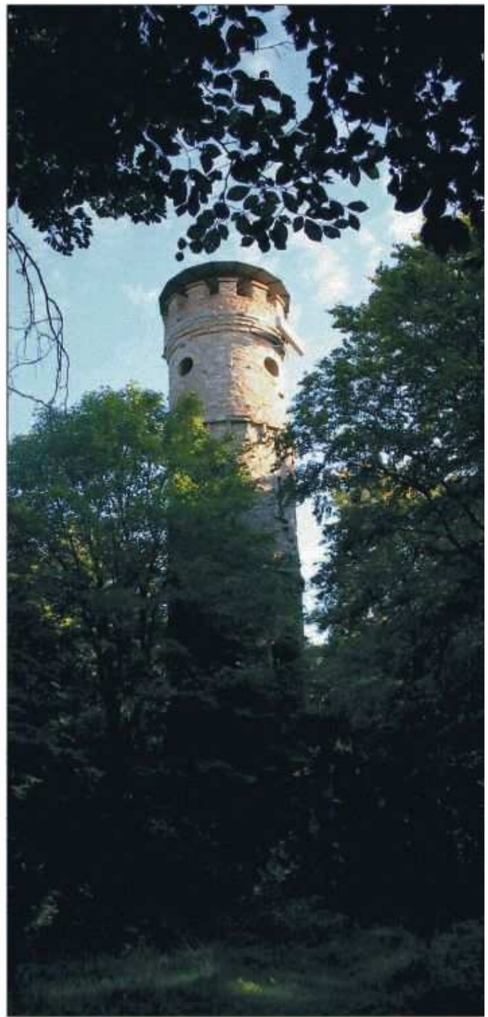
Die Alteburg bei Seesbach ist eine viel besuchte Attraktion. Von dem Turm aus kann man über den gesamten Naturpark Soonwald-Nahe blicken. Dennoch wollen die Seesbacher dem Trägerverein nicht beitreten. ■ Foto: Andreas Nitsch ■ S2009ni1
