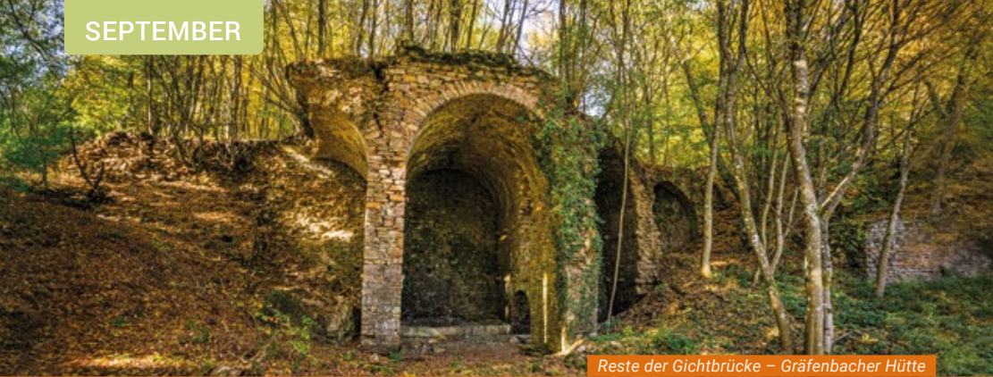
Reste der Gichtbrücke – Gräfenbacher Hütte
