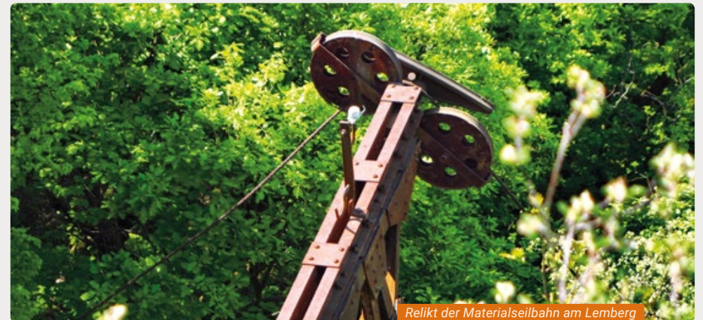
Relikt der Materialseilbahn am Lemberg
